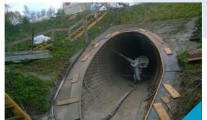
**BÉTON PROJETÉ BÉTOFER HD ET MORTIER PROJETÉ PSM**
